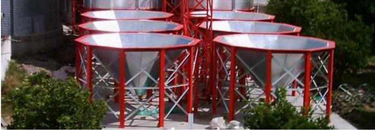
Şekil 91. Konik Tabanlı Silo Konik Tabanları
