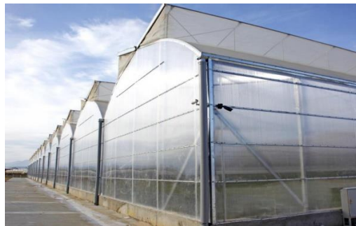
Şekil 7: Polikarbon Sera Yan Duvarları
