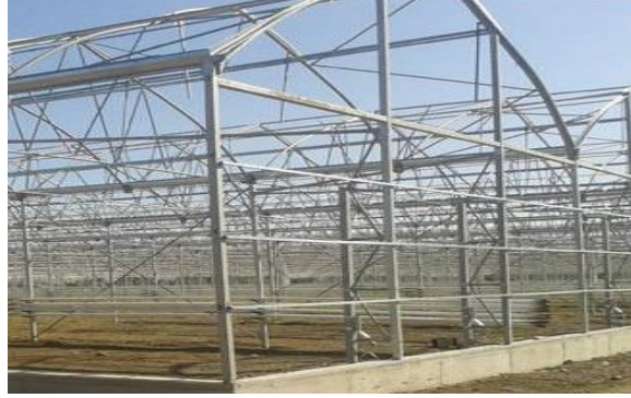
Şekil 3: Çevre Temel ve Yan Perde Betonu
