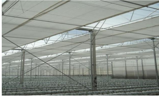
Şekil 9: Isı Perdeleri Örneği
