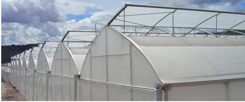
Şekil 6: Sera Havalandırma Örneği
