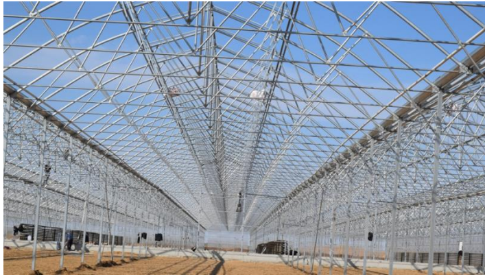
Şekil 4: Sera Gotik Tip Makas Yerleşimi Örneği
