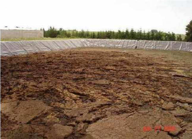
Şekil 35 Digestate depolama için açık havuz lagünleri
