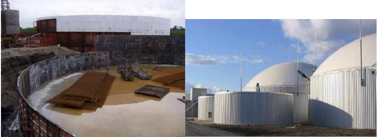
Şekil 27 İnşa Halinde Dikey Çürütücü (Solda), Gaz geçirmez membran ile kaplı dikey çürütücüler. (Sağda)
