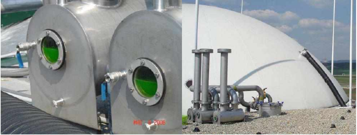
Şekil 30 Emniyet basınç tesisleri ve vanalar
