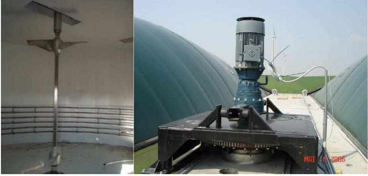
Şekil 28 Asma kanatlı karıştırıcılar (solda) ve karıştırma motoru (sağda)
