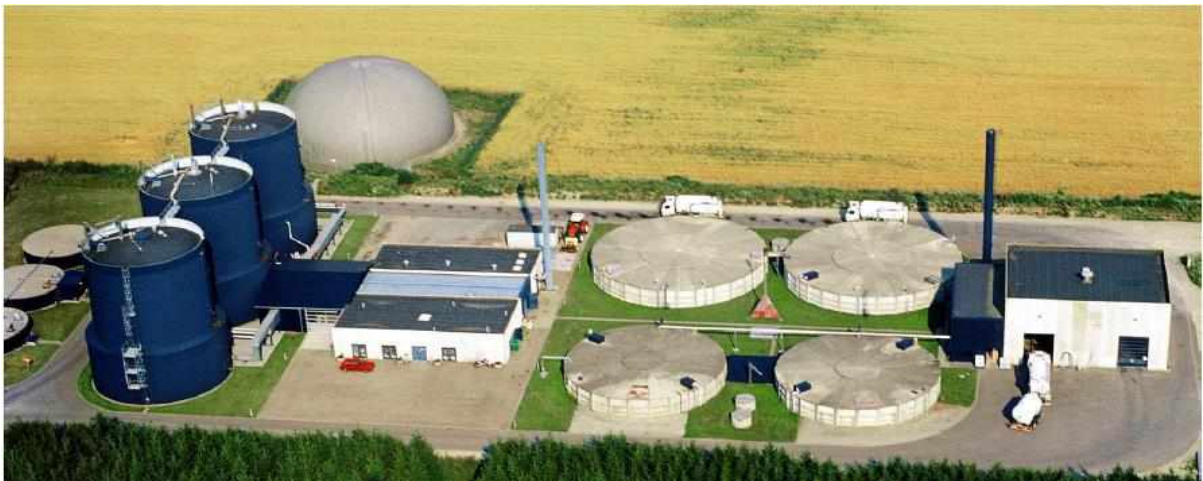
Şekil 12 Merkezi Ortak Bir Biyogaz Tesisi, Danimarka
