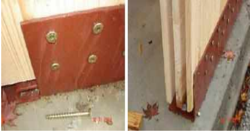
Şekil 8 Duvar ve Beton Zemin Bağlantıları
