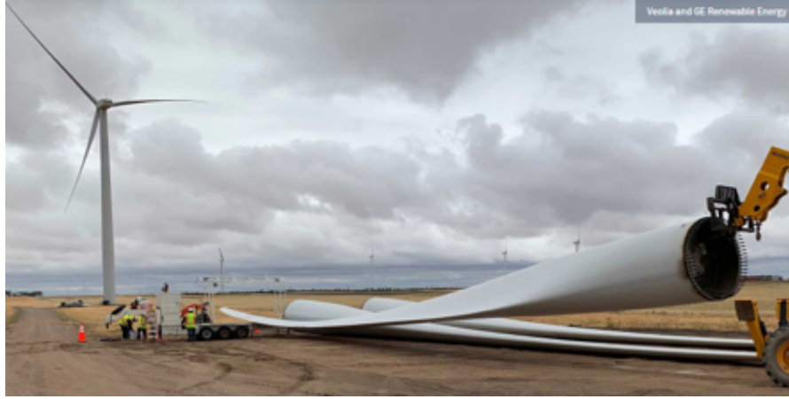
Şekil 10: Geri Dönüştürülmek Üzere Hazırlanan Türbin Kanatları
