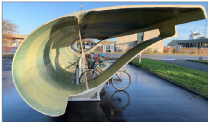
Şekil 9: Aalborg, Danimarka’da Türbin Kanadından İnşa Edilmiş Bisiklet Korunağı
