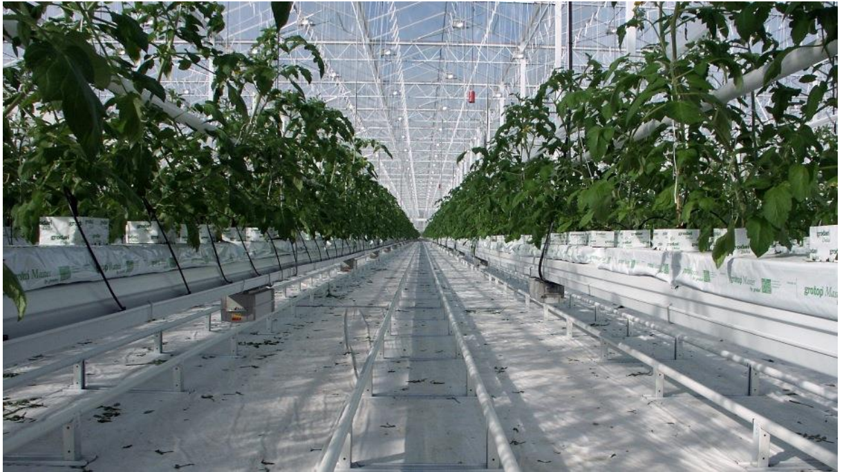
Resim 2: Isıtma Sistemi ve Askılı Yerleştirme Olukları
