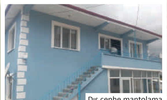
Dış cephe mantolama
